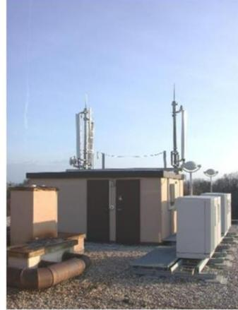
3 secteurs → minimum 3 antennes et 3 radios TRX (ensemble émetteurs récepteurs à 1 fréquence porteuse)
